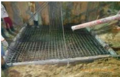
**Gambar 10. Pengecoran Plat Poer**
