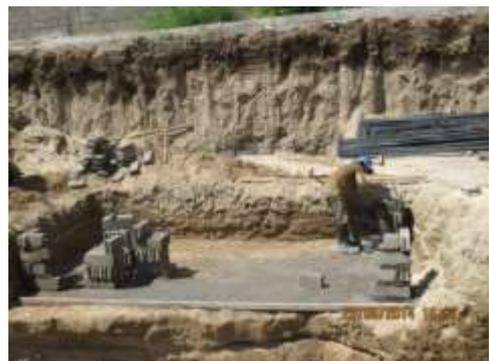
**Gambar 8.** Pekerjaan bekisting batako
